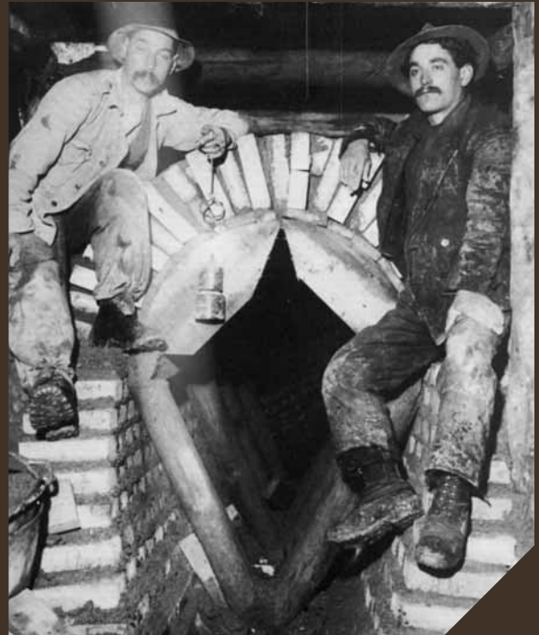
Kanalbaustelle um 1900. Repro Baugeschichtliches Archiv Sewer canal construction-site, ca. 1900.
